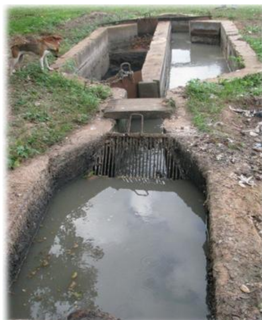
Imagem 10.1: Vista do tratamento preliminar.
